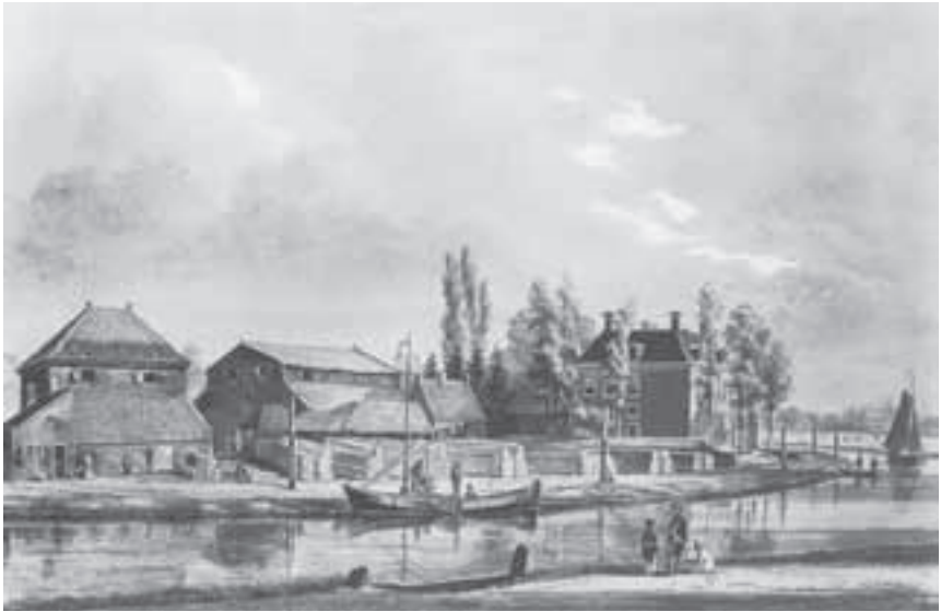
Afb. 2. Cromwijck, huis en steenfabriek liggen aan het jaagpad (let op de rolpalen). Op deze tekening van Lutgers (1857) is geen spoor van een beschoeiing met dakpannen te bekennen.
