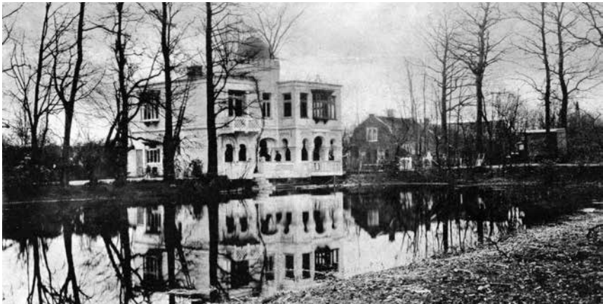
Afb. 13 Het Plantagehuis na de verhoging in 1908, waarbij een lage vierkanten toren met koperen koepel op de verdieping werd gebouwd. (Coll. Zanting)
