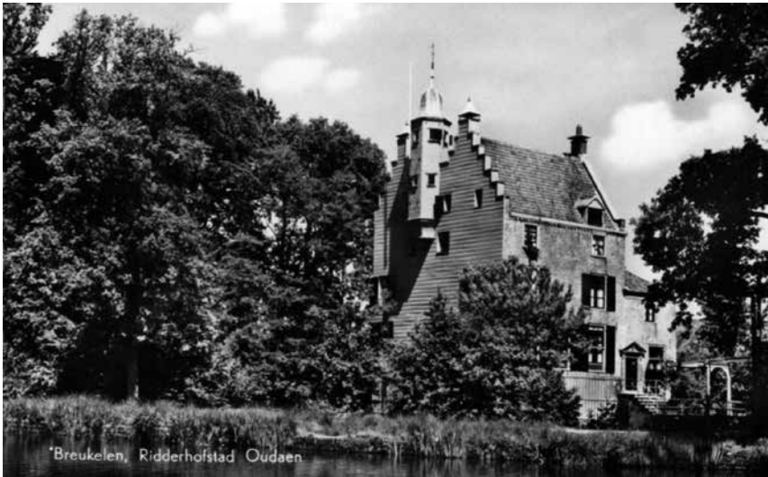
Afb. 17 Gerrit Duuring kocht in 1827 Kasteel Oudaen en zou tegen de in slechte staat verkerende westgevel een houten betimmering aanbrengen.
