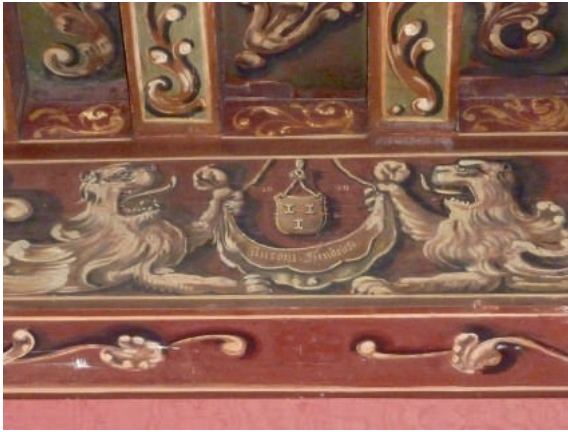
Afb. 14 Strijkbalk van het moer- en kinderbintenplafond van de zaal met het opschrift 'Antoni Hendricks', het wapen van Zuylen en het jaartal '1629'.
