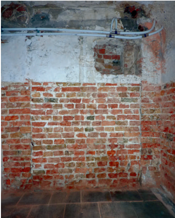
Afb. 3 Zicht vanuit de kelder naar de bouwmuur van het voorhuis. Detail van de secundaire dichtzetting van een doorgang naar een voormalige trap of kelderruimte onder het voorhuis. De kelder werd vermoedelijk gedicht in 1628.
