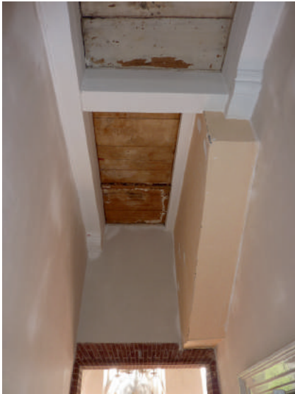
Afb. 20 Zicht vanuit de gang naar het voorhuis met de balklaag. Waarschijnlijk was de spiltrap in een apart portaal opgenomen, en is de console links naar achteren verplaatst, op het moment dat de gang naar de tuinkamer werd doortrokken.
