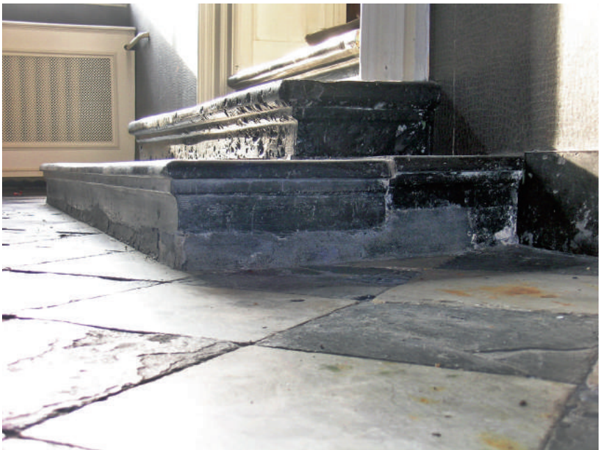
Afb. 25 Het voorhuis met de opgang naar de opkamer. Detail van de – hergebruikte – hardstenen treden, getuige het forse mortelbed onder de treden.
