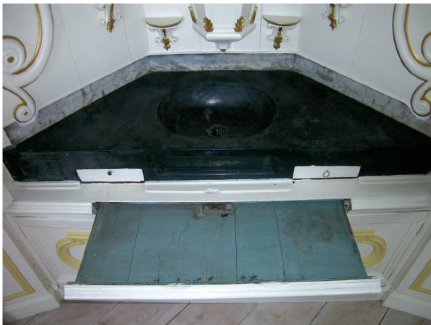
Afb. 23 Detail van de buffetnis in de tuinkamer met het zwart marmeren bassin, twee laadjes en een uitschuifplank. Hierop bevindt zich een grijsblauwe afwerklaag, een afwerking die – hoewel later aangebracht – mogelijk gebaseerd is op de oorspronkelijke kleurstelling van de tuinkamer.
