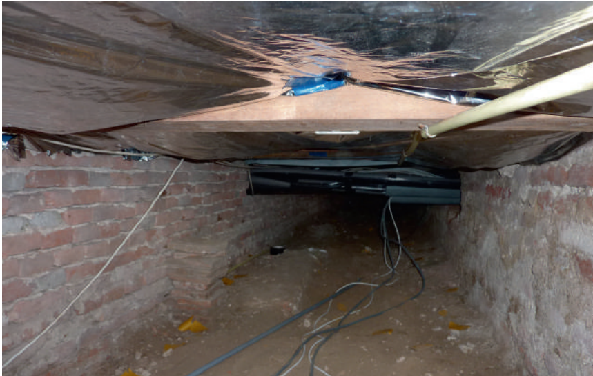
Afb. 9 Zicht in de kruipruimte tussen de noordelijke keldermuur onder de zaal (links) en de scheidingmuur tussen de zaal en de gang (rechts). Halverwege links is een schuin lopende fundering aanwezig, waarschijnlijk van een voorganger van het huidige gebouw.
