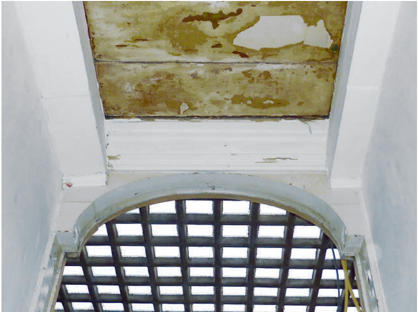
Afb. 19 Zicht in de gang naar de oostzijde. Rechts is een smallere strijkbinde zichtbaar, de oorspronkelijke eindwand van de keuken. Links een normale balkmaat, waartegen de 18 de -eeuwse gangwand werd geplaatst.
