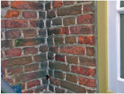
Afb. 5 Aansluiting tussen de achtergevel van het voorhuis en de toren. Het metselwerk is in verband gemetseld.
