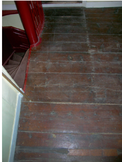
Afb. 21 Detail van de vloerdelen nabij de spiltrap. Op de vloer zijn sporen van een tweetal wandstijlen en een spijkerlijn van een oudere – genagelde – vloerbedekking in dit portaal.
