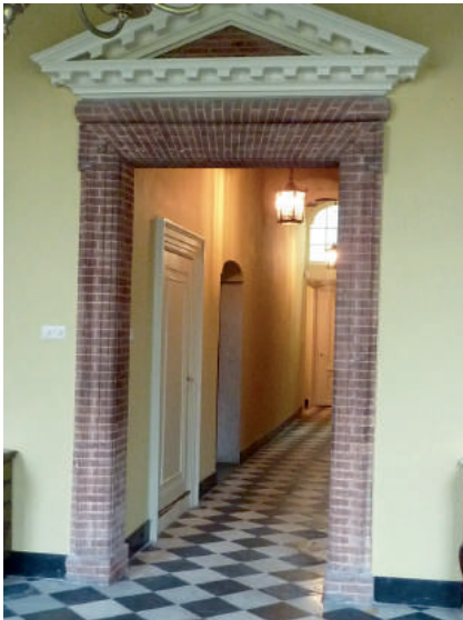
Afb. 32 De hal na de werkzaamheden uit 2009 met de gereconstrueerde 17 de -eeuwse kleurstelling van het poortje en de wanden.
